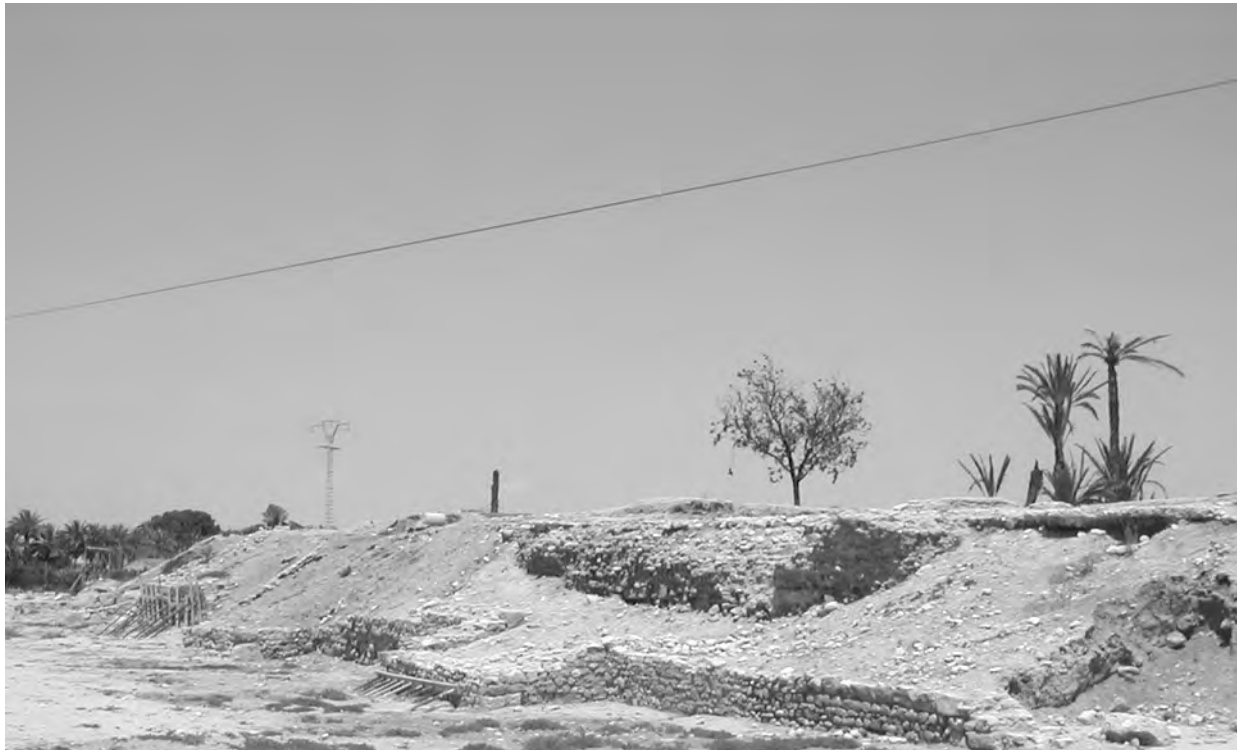
Figura 11. Vista desde el suroeste de las construcciones de refuerzo lateral de las termas occidentales.
